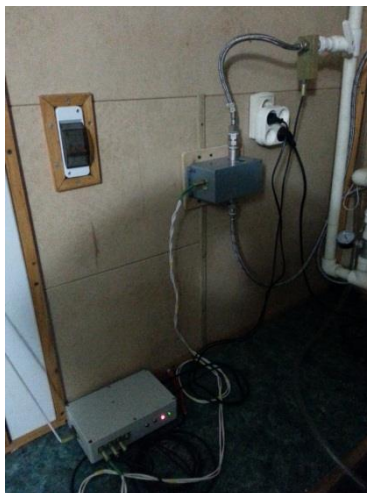
Рисунок 4 – Проточный флуориметрический комплекс в трюме НИС «Денеб»
